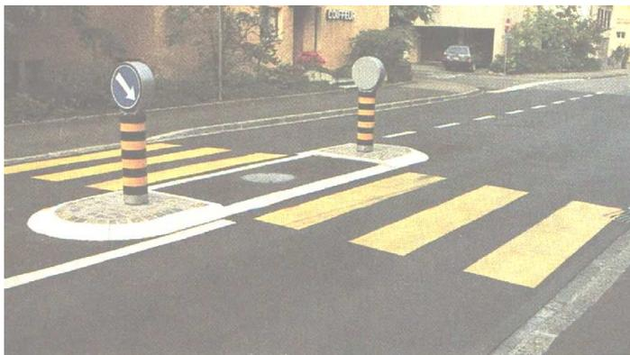
Figura 1. Esempio di attraversamento protetto da isola salvagente centrale.
